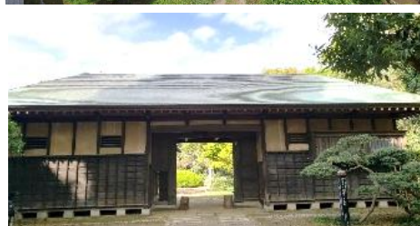
染谷家住宅 主屋(上)と長屋門(下)
